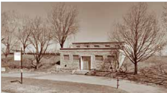
Entrée du réservoir d'eau potable Rosemont situé sur la 16 e avenue, sous le parc Étienne-Desmarteau
