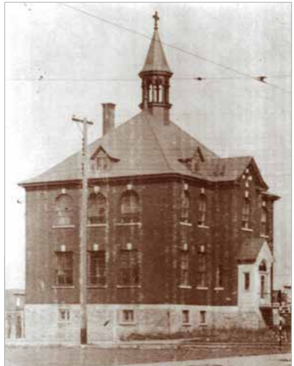
École de la Visitation. Construite en 1906 à l'angle du boulevard Rosemont et de la 9 e Avenue, elle servait d'école et d'église. Cet édifice n'existe plus aujourd'hui.
