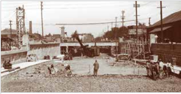
Construction du tunnel à l'angle du boulevard St-Joseph et de la rue Iberville au début des années 1930.
