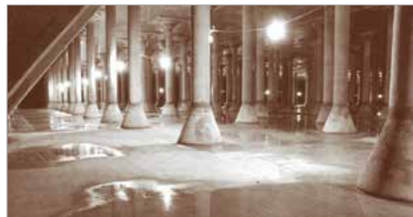
Intérieur du réservoir d'eau potable Rosemont
